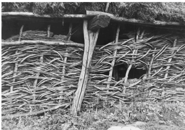
Foto 2. Vitstest punutud ja saviga tihendatud laudasein
